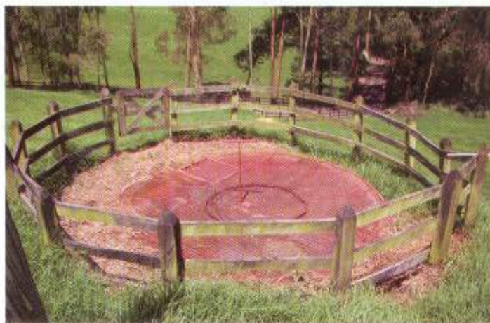
Protección pozo estercolero
