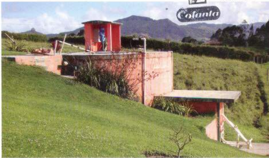
Tanque estercolero. (Ubicación adecuada).
