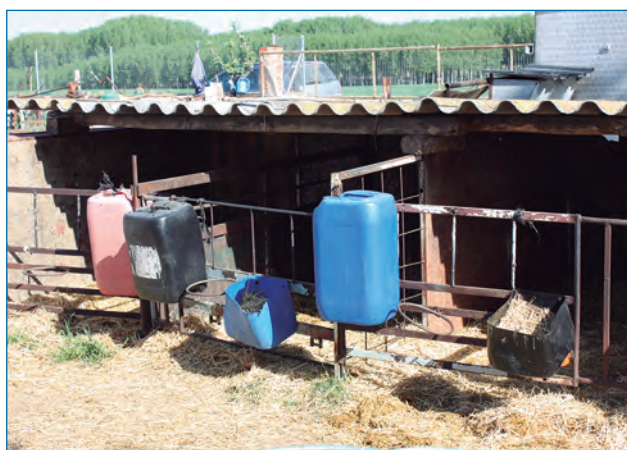
Figura 16. Boxes y corrales para terneros fabricados con material de desecho
