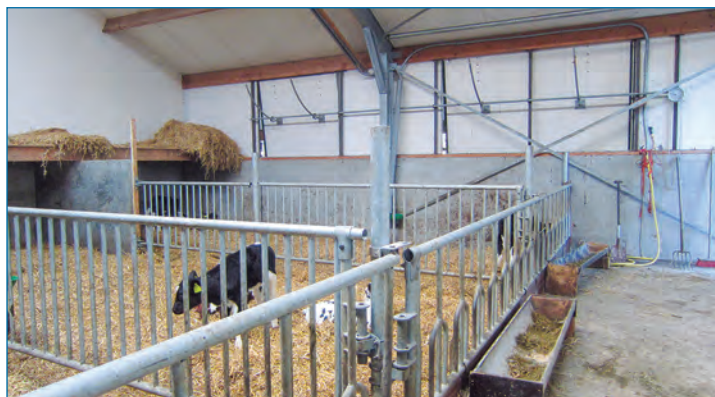
Figura 2. Cubierta de placas aislantes
