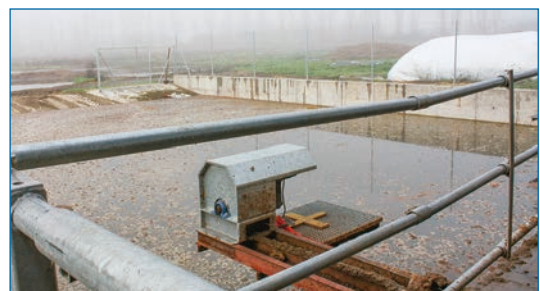
Figura 1. Almacenamiento de purín en fosa de hormigón
