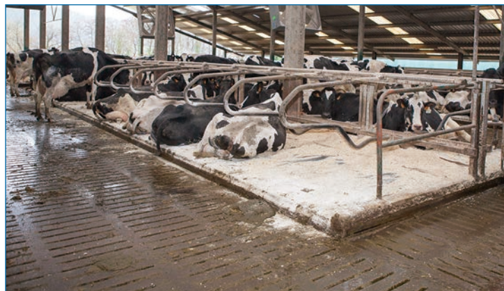
Figura 7. Enrejillado de drenaje de 2,5 m de longitud.
