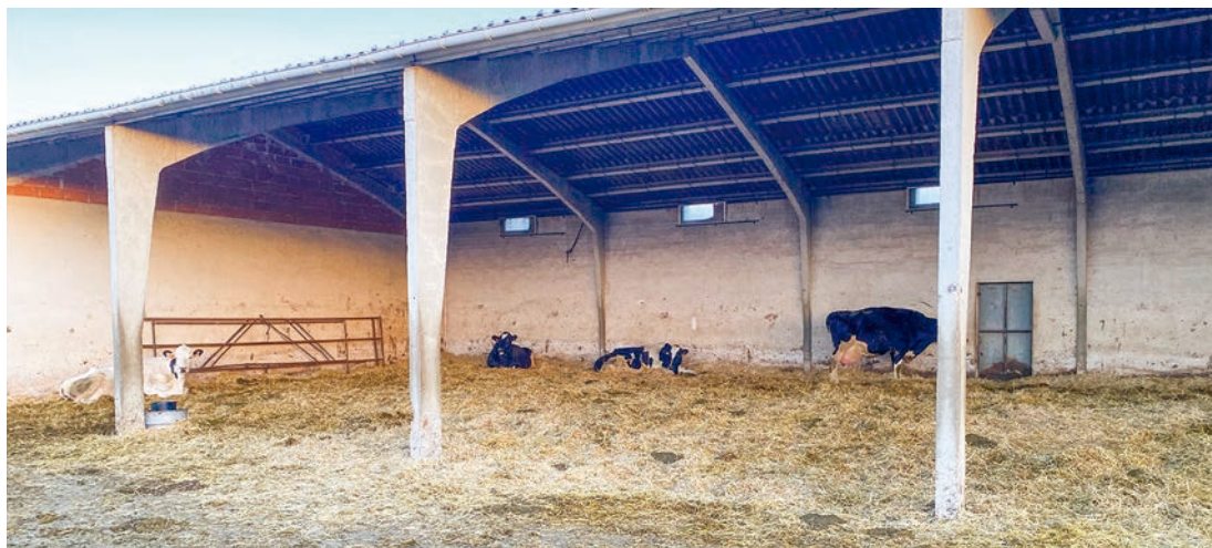
Aspecto de una parte de la nave cubierta
