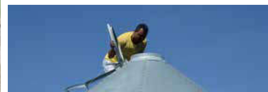
Inspección y limpieza del silo.
