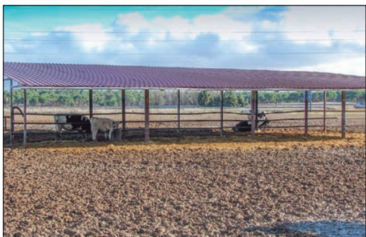
Figura 8. Estructura fija con cubierta de chapa
