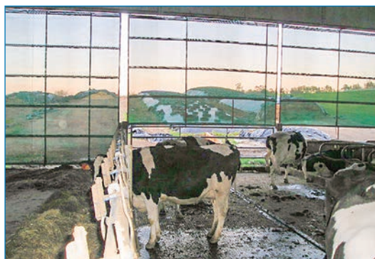
Figura 11. Cortavientos en el extremo de la nave
