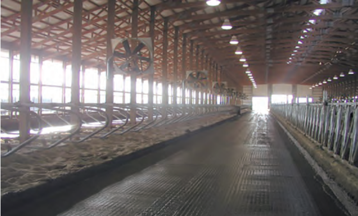
Figuras 2a y 2b. Ventiladores HVLS correctamente colocados sobre la zona de ejercicio y de reposo de las vacas.
