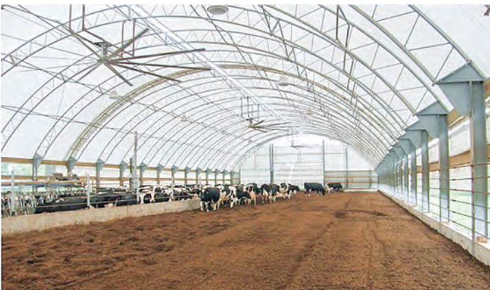
Figura 3. Ventiladores HVLS incorrectamente colocado sobre un pasillo de distribución de alimento.
