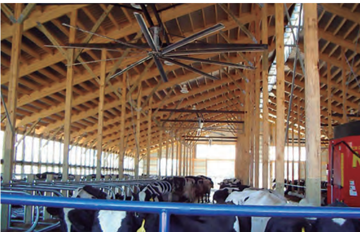
Figuras 2a y 2b. Ventiladores HVLS correctamente colocados sobre la zona de ejercicio y de reposo de las vacas.
