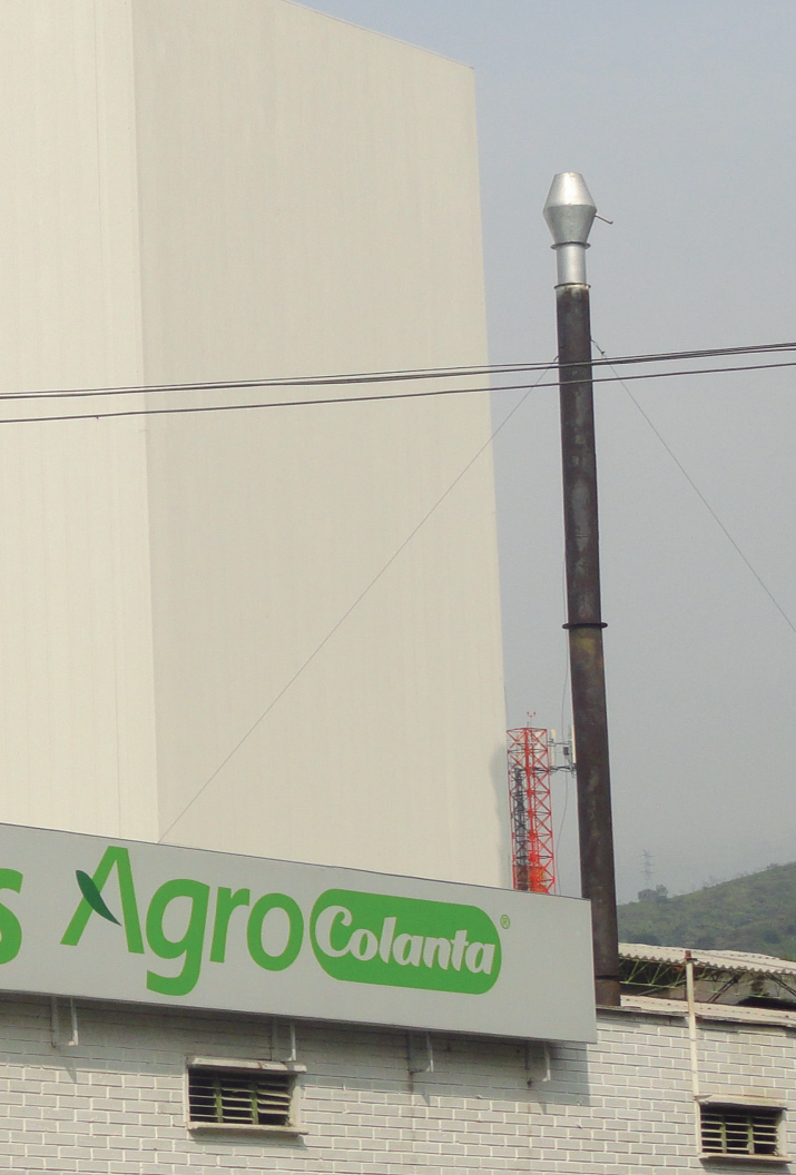
EXTERIOR SILOS PLANTA CONCENTRADO. ITAGÜÍ, ANT.
