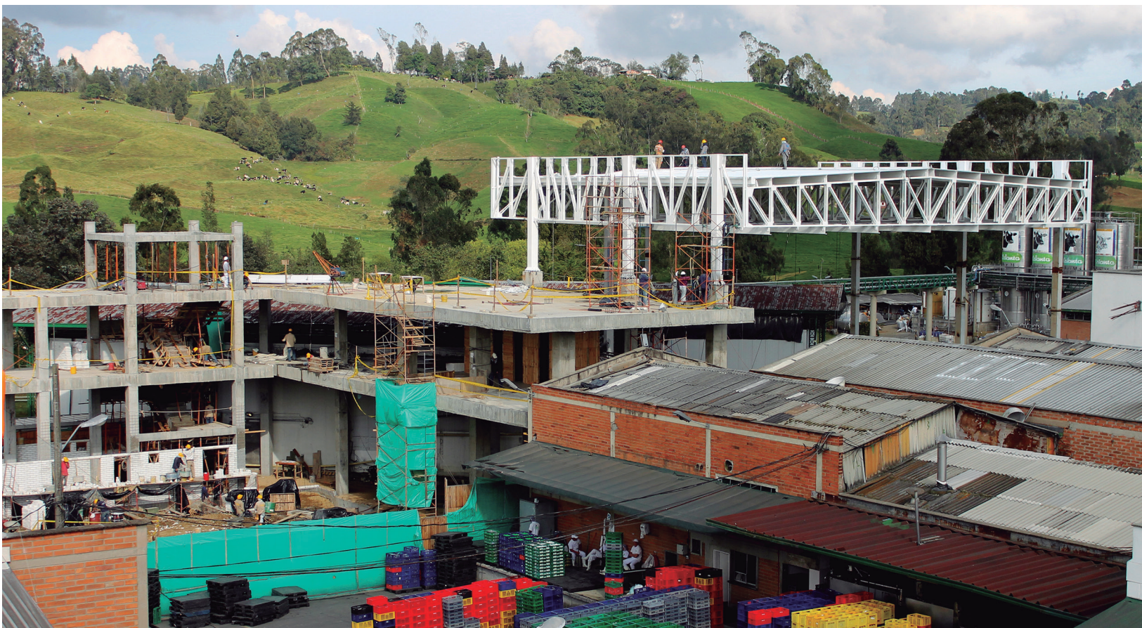
CONSTRUCCIÓN CENTRO DE DISTRIBUCIÓN SAN PEDRO
