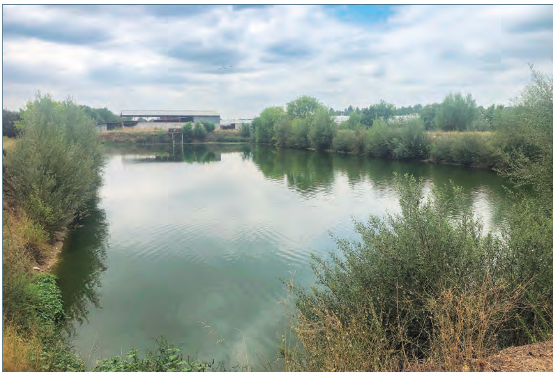
Figura 2. Balsa para la decantación del agua de limpieza y posterior reutilización.
