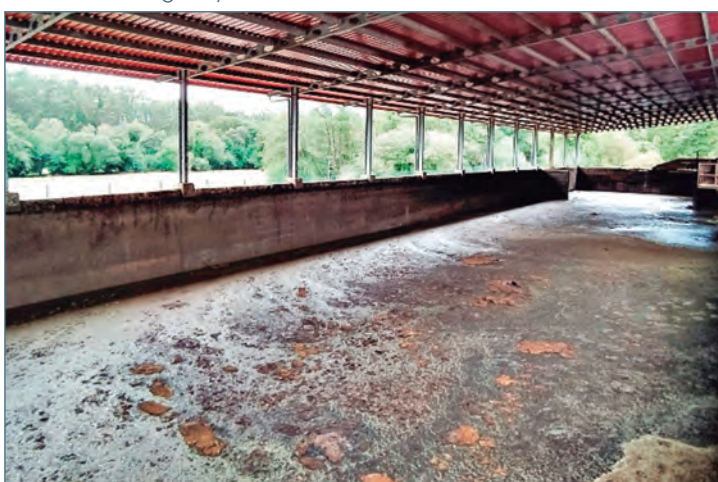
Figura 5. Cubrir la fosa de purín aumenta el volumen de agua recogida y evita llenar la fosa innecesariamente
