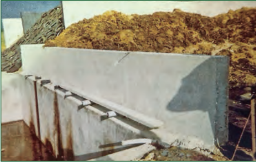
Figura 2. Orificios de drenaje en un estercolero
