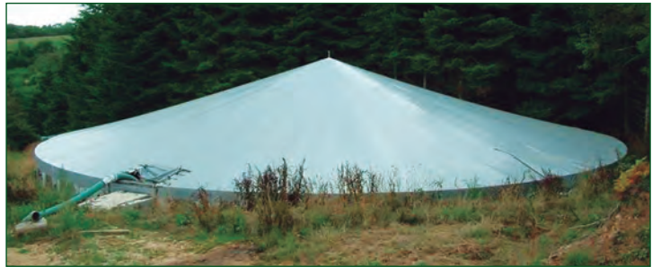
Figura 8. Tanque cubierto por una estructura flexible apoyada en el contorno del depósito y en un mástil central
