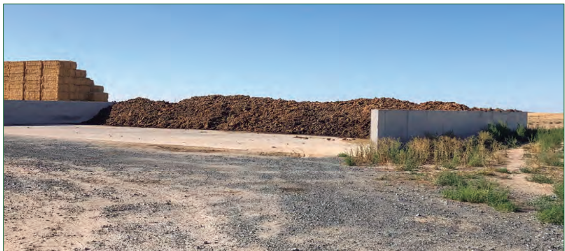
Figura 1. Estercolero con muros de contención
