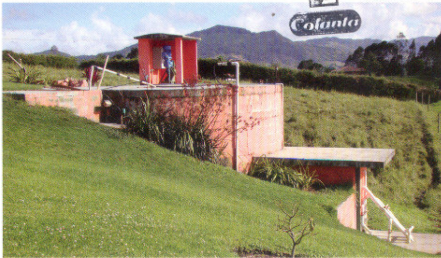
Tanque estercolero. (Ubicación adecuada).
